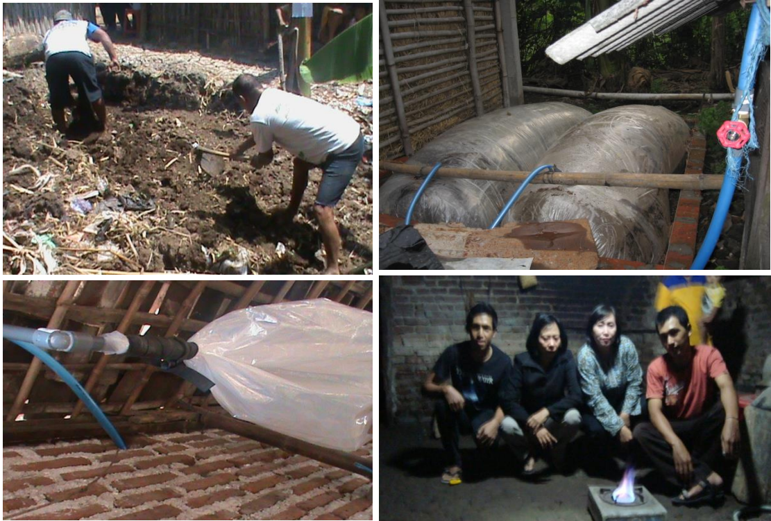
Gambar 3. Pembuatan Instalasi Biogas
