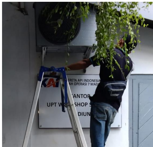
Gambar 6. Perbaikan AC Di Stasiun Kereta Api
