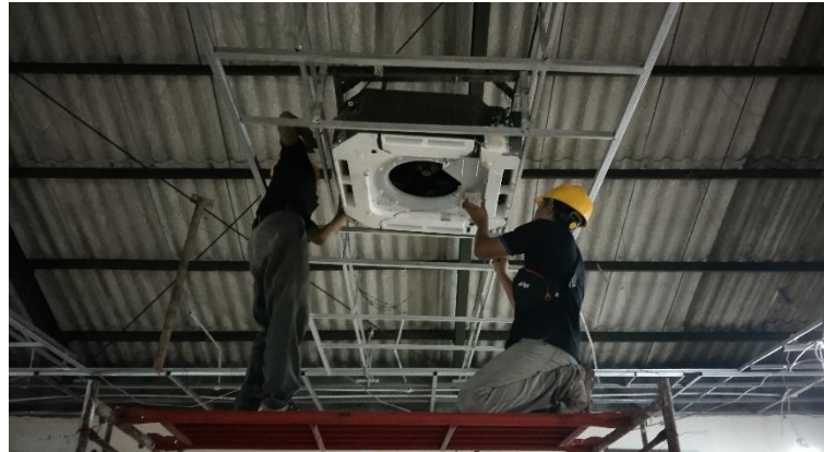
Gambar 9. Pemasangan AC di PT.Pertamina
